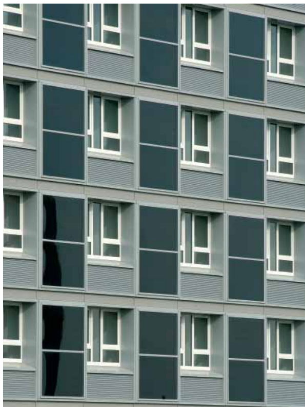
Mit Solarkollektoren bestückte Fassade
